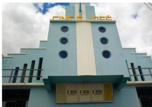
Figura 7 - O Cine Teatro São José em Afogados da Ingazeira -PE
